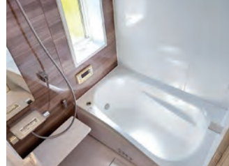
新設のユニットバス
